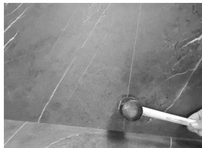
En la primera fila, golpear con el martillo en el lado corto para cerrar el clic.
