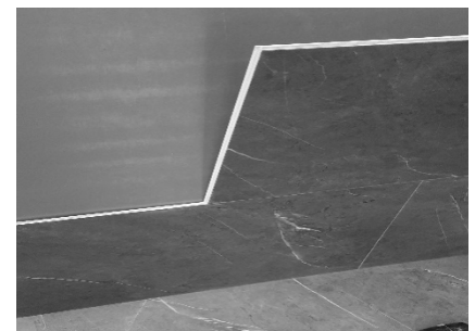
En la siguientes filas, insertar los lados largos a 45º grados
